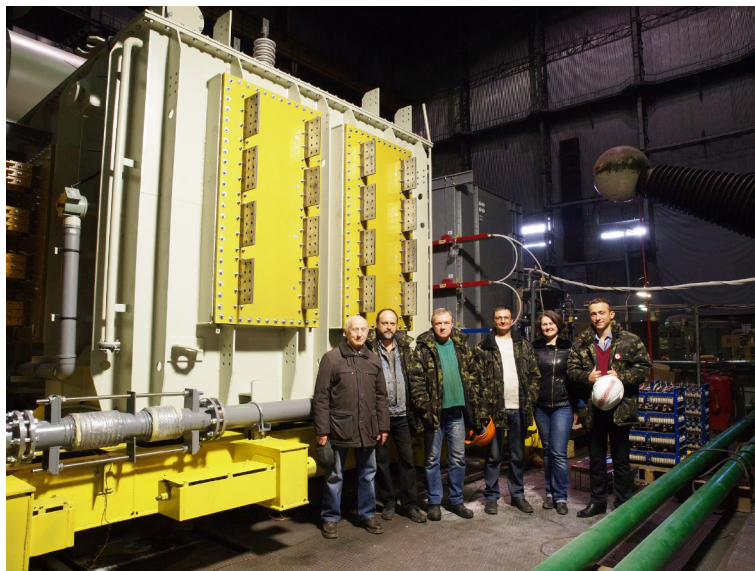
Фото 9 – Группа испытателей ВИТ на фоне преобразовательного трансформатора ТНЦНПУД-63000/10 для питания преобразователя 180 кА печей графитизации
