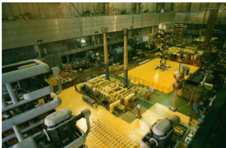
Фото 2 – Вид внутри Большого высоковольтного зала
