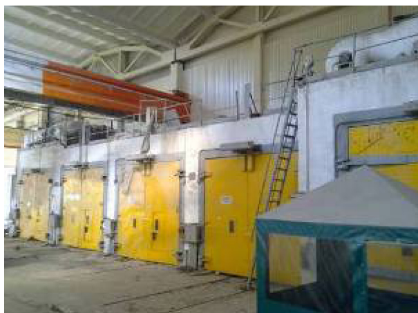
Испытательные стенды (камеры)
